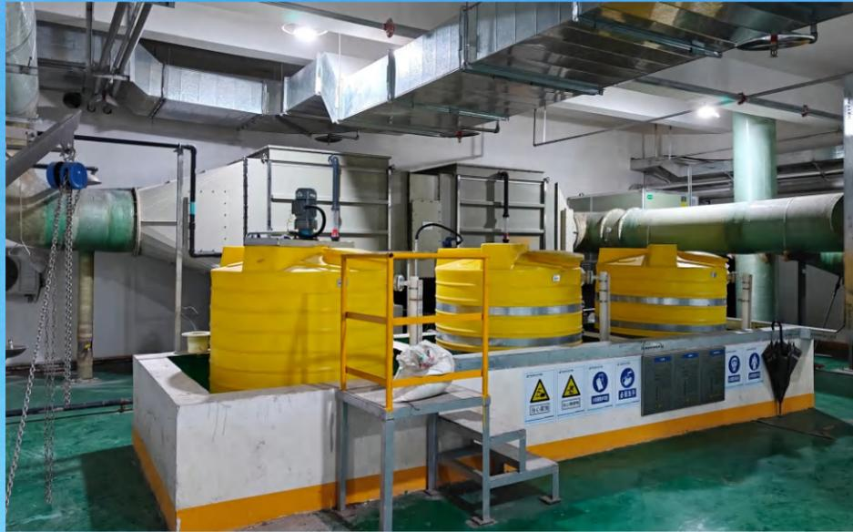
青岛全地下某生态水厂恶臭气体治理项目, 处理风量: 20000m<sup>3</sup>/h, 散发点: 污水池, 处理因子: 硫化氢、氨气、臭气浓度; 浓度: 5-100mg/m<sup>3</sup>, 臭气浓度 20000, 工艺流程: GraFi-A+GraFi-C+引风机+排气筒, 治理效果: 处理效率 > 95%, 符合《恶臭污染物排放标准》(GB14554-93)、《城镇污水处理厂臭气处理技术规程》(CJJ/T243-2016)。
