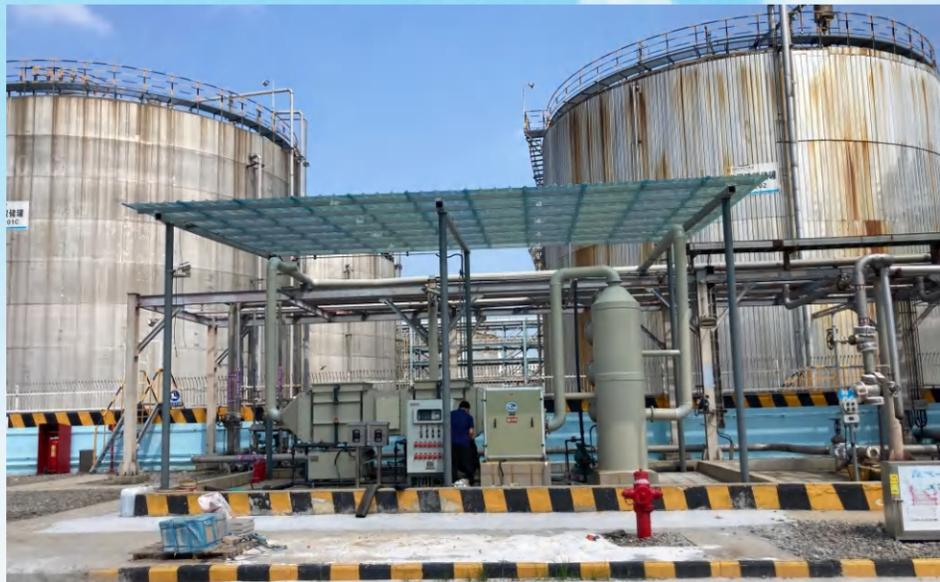
平煤神马集团某公司含硫酸雾废气治理项目,处理风量:1000m<sup>3</sup>/h,散发点:硫酸储液罐;处理因子:三氧化硫、硫酸雾;浓度:100-500mg/m<sup>3</sup>,工艺流程:预处理塔+两级GraFi-A+引风机,治理效果:处理效率>95%,符合《硫酸工业污染物排放标准》(GB26132-2010)。
