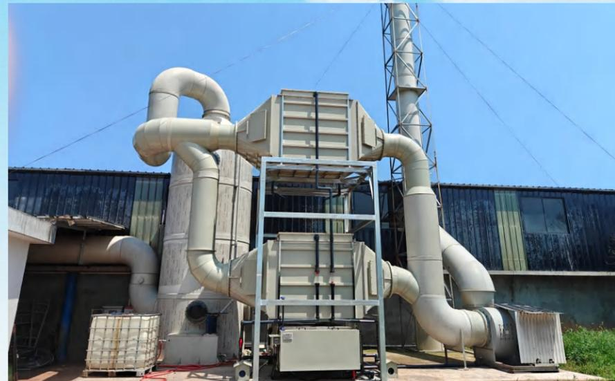
浙江某农牧公司含硫化氢复杂废气治理项目,处理风量:20000m<sup>3</sup>/h,散发点:污水池、污泥间,处理因子:硫化氢、臭气浓度;浓度:10-100mg/m<sup>3</sup>,工艺流程:预处理塔+GraFi-A+引风机+排气筒,治理效果:符合《恶臭污染物排放标准》(GB14554-201X)(征求意见稿)。
