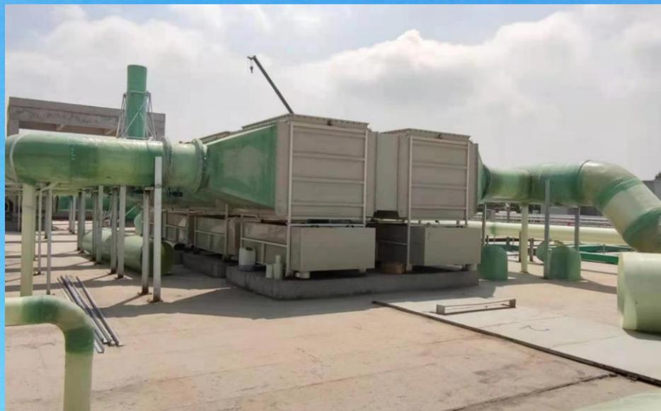
山东博兴县某污水厂恶臭气体项目, 处理风量:  $40000\text{m}^3/\text{h}$ , 散发点: 污水池、污泥间, 处理因子: 硫化氢、氨气、臭气浓度; 浓度:  $5-100\text{mg}/\text{m}^3$ , 臭气浓度 20000, 工艺流程: GraFi-A+GraFi-C+DDBD(预留)+引风机+排气筒, 治理效果: 处理效率  $>95\%$ , 符合《恶臭污染物排放标准》(GB14554-93)、《城镇污水处理厂污染物排放标准》(GB18918-2002)。
