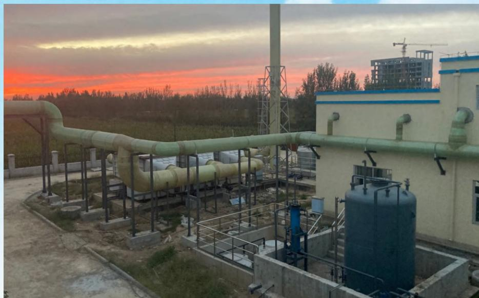
禹城某污水处理厂恶臭气体项目, 处理风量:  $35000\text{m}^3/\text{h}$ , 散发点: 污水池、污泥间, 处理因子: 硫化氢、氨气、臭气浓度; 浓度:  $5-100\text{mg}/\text{m}^3$ , 臭气浓度 20000, 工艺流程: GraFi-A+GraFi-C+引风机+排气筒, 治理效果: 处理效率  $>95\%$ , 符合《恶臭污染物排放标准》(GB14554-93)、《城镇污水处理厂污染物排放标准》(GB18918-2002)。
