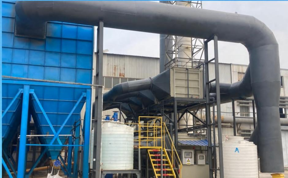
洛阳某铝业公司含二氧化硫废气治理项目,处理风量:100000m<sup>3</sup>/h,散发点:熔炼炉,处理因子:二氧化硫;浓度:100-500mg/m<sup>3</sup>,工艺流程:列管降温+布袋除尘+GraFi-A+引风机+排气筒,治理效果:二氧化硫排放≤30mg/m<sup>3</sup>,符合河南省《工业炉窑大气污染物排放标准》(DB41/1006-2020)。
