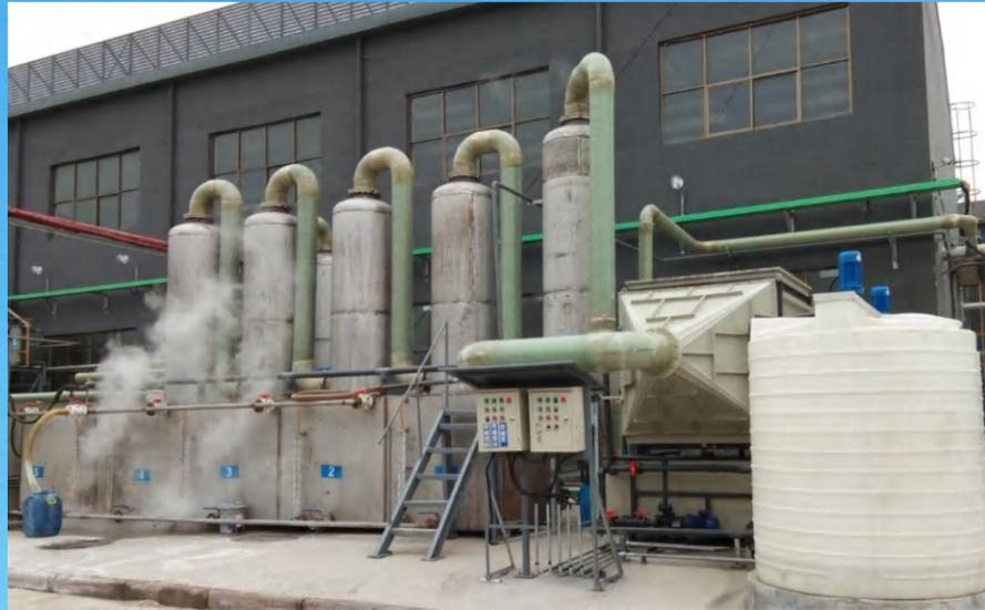
沁阳某化工企业含硫化氢废气治理项目,处理风量:3000m<sup>3</sup>/h,散发点:蒸发釜、污水池,处理因子:硫化氢;浓度:1000-5000mg/m<sup>3</sup>,工艺流程:五级预处理塔+RPFA+引风机+排气筒,治理效果:硫化氢<5ppm,符合《恶臭污染物排放标准》(GB14554-201X)(征求意见稿)。
