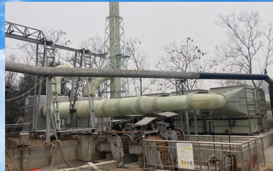
沁阳某污水处理厂恶臭气体治理项目, 处理风量:  $56000\text{m}^3/\text{h}$ , 散发点: 污水池、污泥间, 处理因子: 硫化氢、氨气、臭气浓度; 浓度:  $5-100\text{mg}/\text{m}^3$ , 臭气浓度 20000, 工艺流程: GraFi-A+GraFi-C+引风机+排气筒, 治理效果: 处理效率  $>95\%$ , 符合《恶臭污染物排放标准》(GB14554-93)、《城镇污水处理厂污染物排放标准》(GB18918-2002)。
