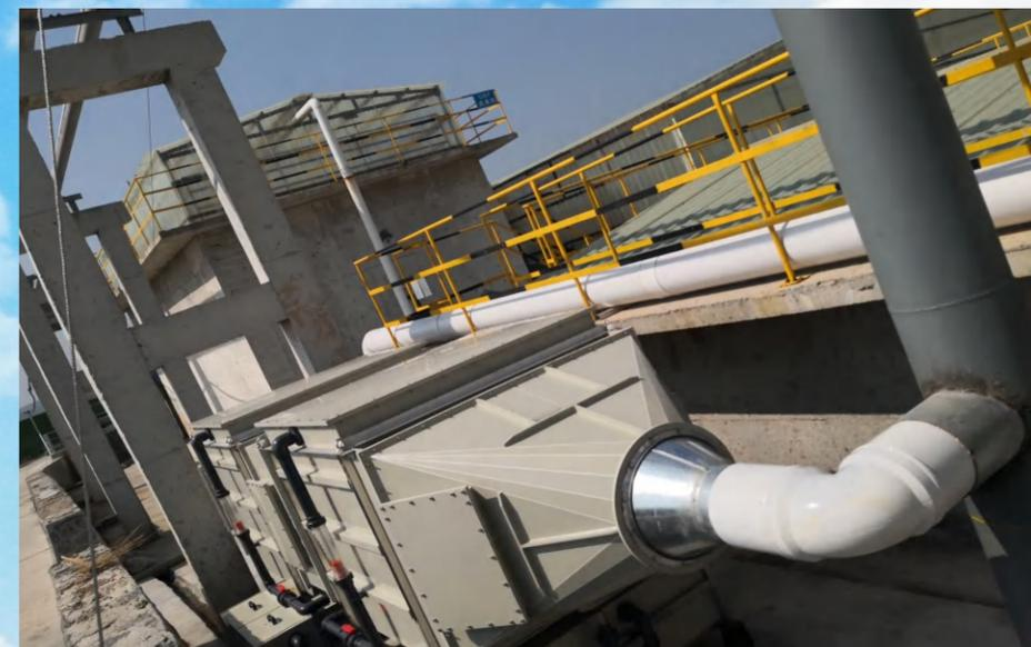
鹤壁某企业污水处理厂恶臭气体治理项目, 处理风量:  $5000\text{m}^3/\text{h}$ , 散发点: 污水池, 处理因子: 硫化氢、氨气、臭气浓度; 浓度:  $5-100\text{mg}/\text{m}^3$ , 臭气浓度 20000, 工艺流程: GraFi-A+GraFi-C+引风机+排气筒, 治理效果: 处理效率  $>95\%$ , 符合《恶臭污染物排放标准》(GB14554-93)。
