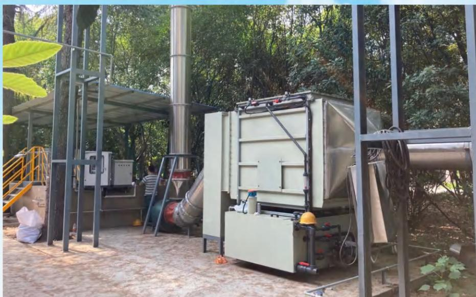
平煤神马某企业含氨气废气治理项目, 处理风量: $5000\text{m}^3/\text{h}$ , 散发点: 浸胶工段, 处理因子: 氨气, 浓度: $50\text{-}300\text{mg}/\text{m}^3$ , 工艺流程: GraFi-C+引风机+排气筒, 治理效果: 符合《恶臭污染物排放标准》(GB14554-201X) (征求意见稿)。
