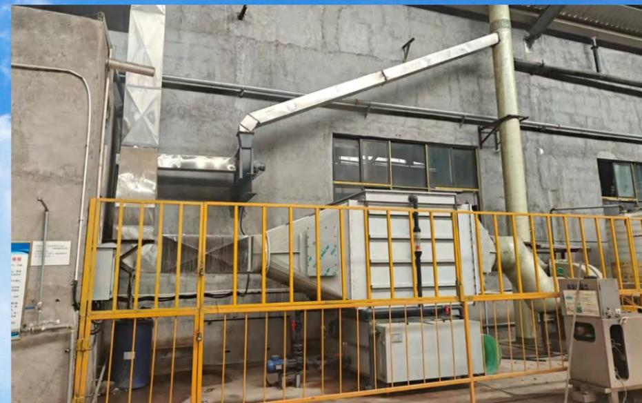
周口某印染企业含氨气废气治理项目, 处理风量: $10000\text{ m}^3/\text{h}$ , 散发点: 氨熏工段, 处理因子: 氨气, 浓度: $100\text{-}2000\text{mg}/\text{m}^3$ , 工艺流程: RPFC+引风机+排气筒, 治理效果: 符合《恶臭污染物排放标准》(GB14554-201X) (征求意见稿)。
