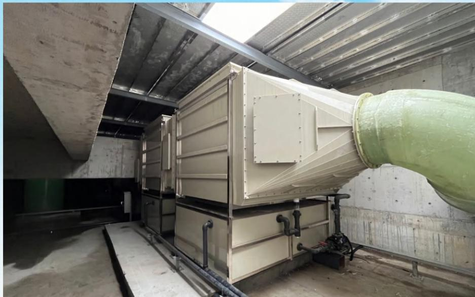
武汉某综合整治生态水厂恶臭气体治理项目, 处理风量: 98000m<sup>3</sup>/h, 散发点: 污水池, 处理因子: 硫化氢、氨气、臭气浓度; 浓度: 5-100mg/m<sup>3</sup>, 臭气浓度 20000, 工艺流程: GraFi-A+GraFi-C+引风机+排气筒, 治理效果: 处理效率 > 95%, 符合《恶臭污染物排放标准》(GB14554-93)。
