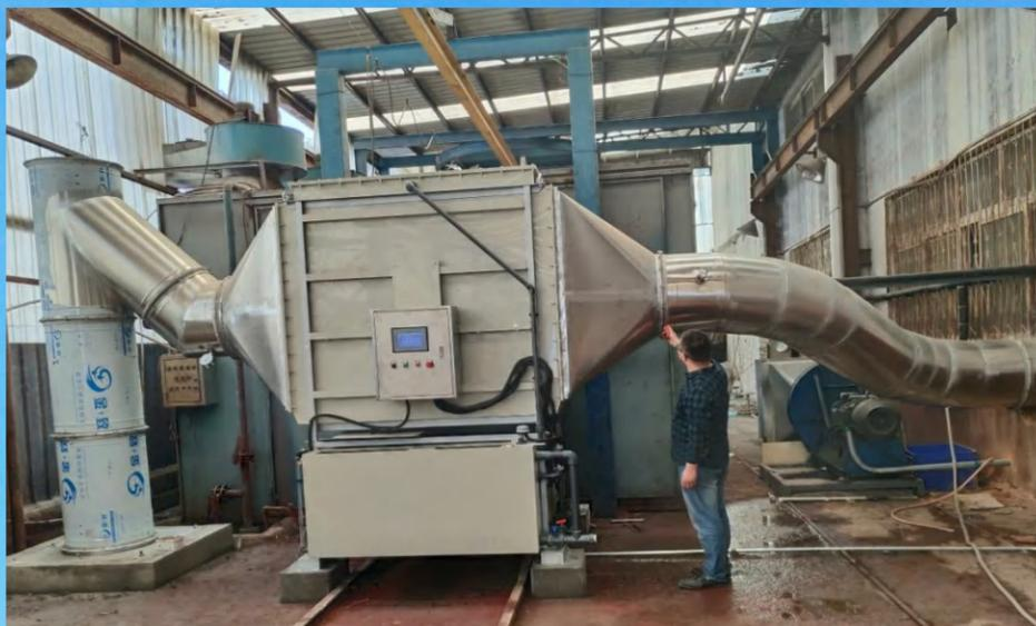
济源某军工企业含氨气废气治理项目, 处理风量 $10000\text{m}^3/\text{h}$ , 散发点: 生产设备, 处理因子: 氨气, 浓度: $500\text{-}1000\text{mg}/\text{m}^3$ , 工艺流程: GraFi-C+引风机 (车间循环), 治理效果: 氨去除效率达99%。
