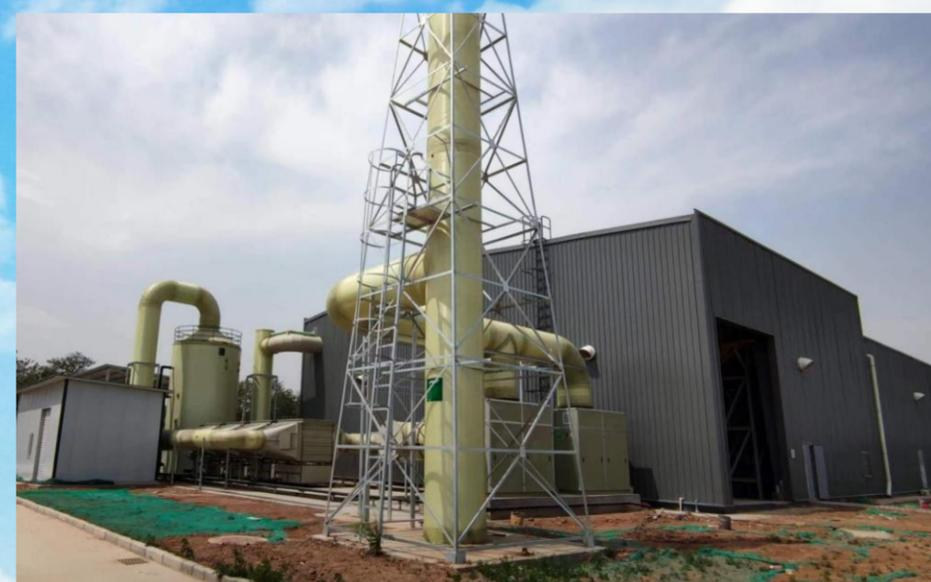
西安某污泥处置厂含氨气复杂废气治理项目, 处理风量: $40000\text{m}^3/\text{h}$ , 散发点: 污泥翻刨、堆放, 处理因子: 氨气、臭气浓度, 氨气浓度: $10\text{-}500\text{mg}/\text{m}^3$ , 臭气浓度20000, 工艺流程: 预处理塔+臭氧+GraFi-C+引风机+排气筒, 治理效果: 氨排放浓度: $0.63\text{ mg}/\text{m}^3$ , 氨处理效率 $>99\%$ , 臭气浓度: 504(无量纲), 符合《恶臭污染物排放标准》(GB14554-201X) (征求意见稿)。
